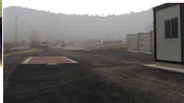
Foto dell'Ecostazione di Calliano in costruzione
